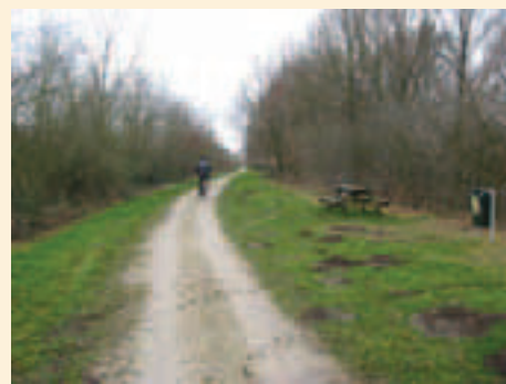
Het fietspad langs het kanaal wordt vernieuwd
