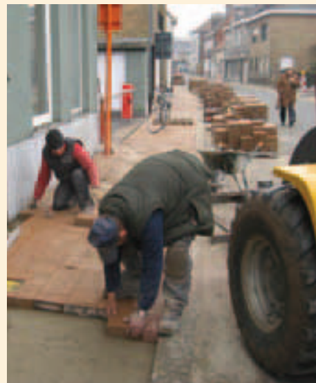
Aanleg van nieuwe voetpaden
